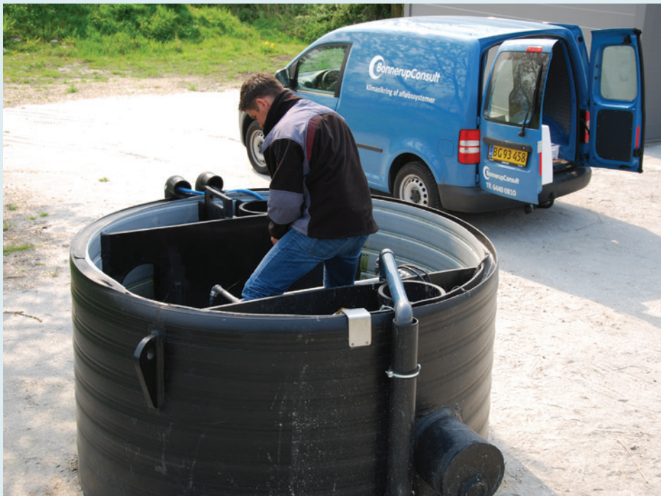
Figur 7: Et af Bonnerup Consults udviklingsprojekter, HydroSeparator, for anvendelse til rensning af overløbsvand på et overløbsbygværk i Kærby, Middelfart Kommune. Projektet er støttet af Miljøministeriet. Billedet er fra Bonnerup Consults hjemmeside.
