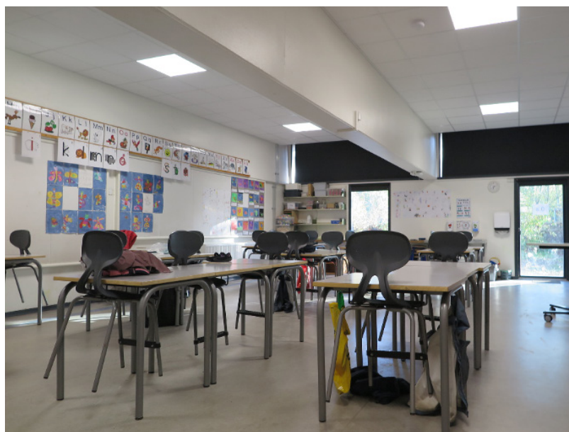
Klasseværelse efter renovering. Ventilation, lys og akustikdæmpning er indbygget i og over loftet. Foto: Kolding Kommune
